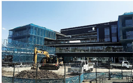
完成間近の新庁舎
