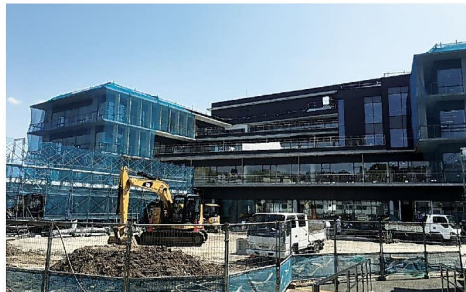
完成間近の新庁舎
