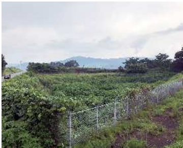
町内の調整池
