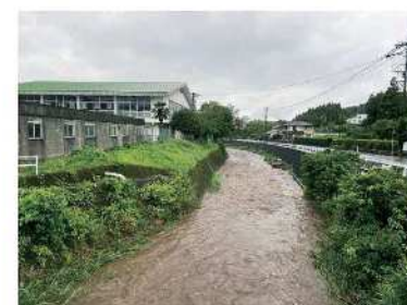
水没の危険がある北小学校周辺地域
