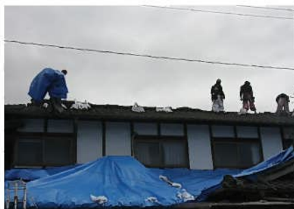
ブルーシート張り(東北からのボランティア)
