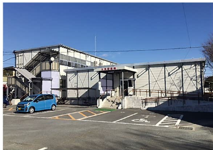
役場仮庁舎(被災により使用できなくなった役場の仮庁舎)
