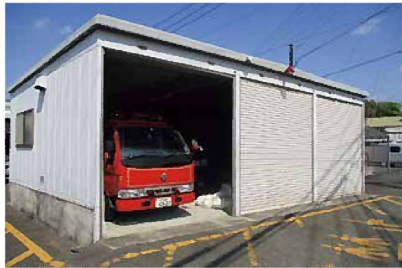
現在の消防倉庫(役場)
