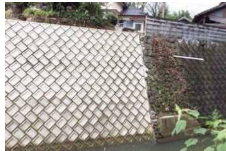
地震による改修
