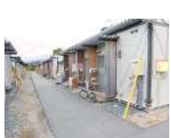
老朽化してきている 仮設住宅
