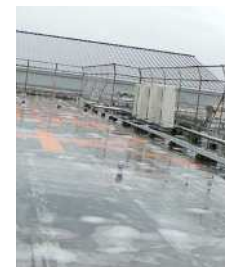
学校施設の屋上
