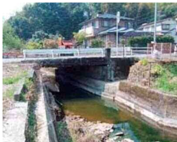
改修予定の鶴口橋
