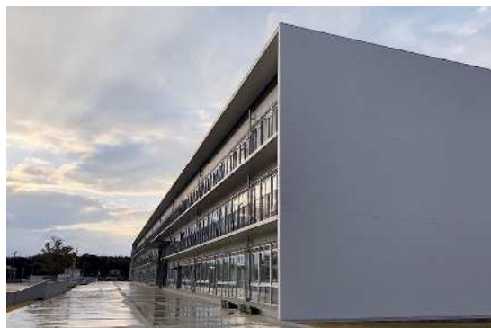
廊下の長さが約130mある校舎
