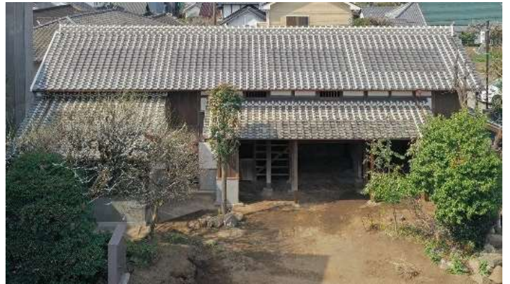
熊本地震復旧後（提供：松井建設株式会社）
