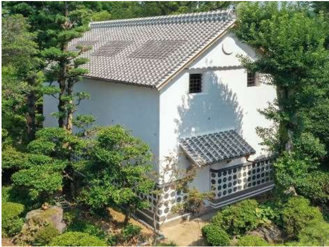
熊本地震復旧後（提供：松井建設株式会社）
