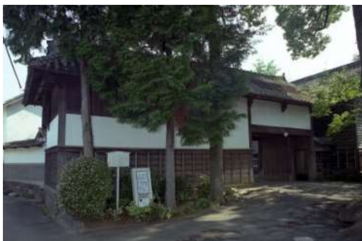
熊本地震被災前 復旧工事中
