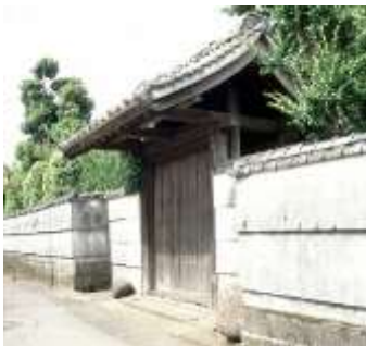
熊本地震被災前 復旧工事中
