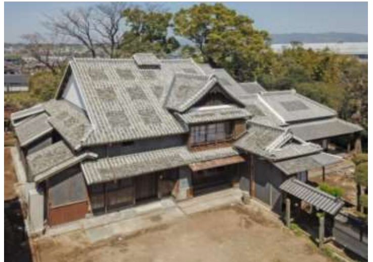
熊本地震復旧後 (提供 : 松井建設株式会社)
