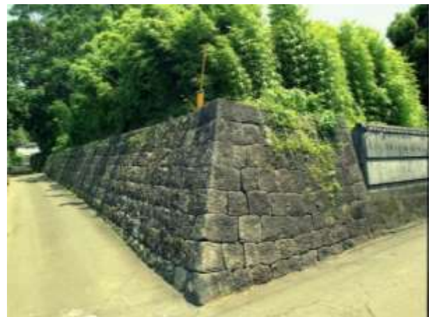
石垣 熊本地震被災前
