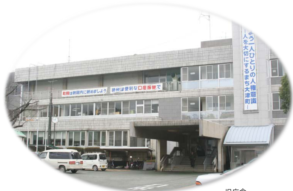
旧庁舎 ～昭和44年10月竣工～
