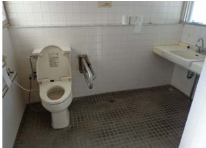
車いす利用者用トイレはあるものの、子連れやオストメイト対応ではない。
