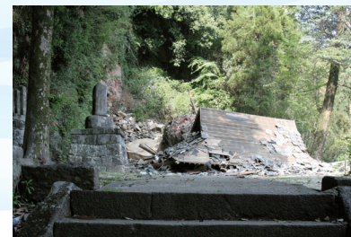
□瀬田神社の被害状況
