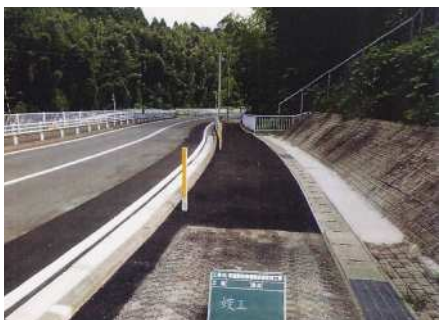
町道駅前楽善線歩道
