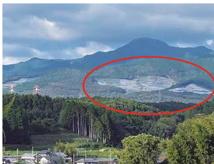
大津町の太陽光発電所
