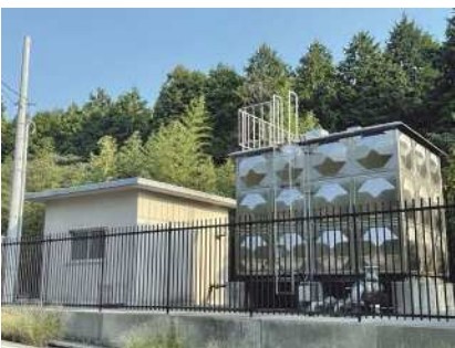
工業用水道施設
